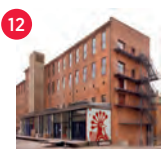
12 Architekturführung Ehemaliges Umspannwerk Marienburg | Druckerei Medien Marienburger Straße 16 10405 Berlin orange architekten
