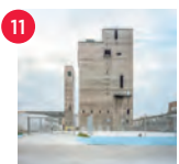
11 Architekturführung San Gimignano Lichtenberg | b+ Prototypenwerkstatt Am Wasserwerk 22F 10365 Berlin b+ und HouseEurope!
