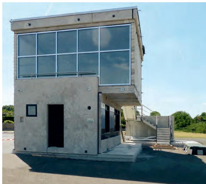
Temporärer Recycling-Pavillon aus wiederverwendeten ost- und west-deutschen Betonbauteilen der Plattenvereinigung auf der Tempelhofer Freiheit
