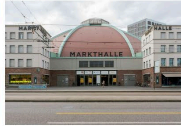
Markthalle Basel laufend
